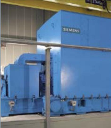
从英国到比利时的一条天然气管线上的一座压缩机站中以 5040 rpm 转速运转的 35 MW 电机
