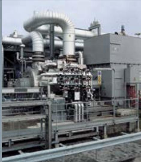
在荷兰格罗宁根市南部以 6300 的转速运转来抽送气体的 23 MW 电机
